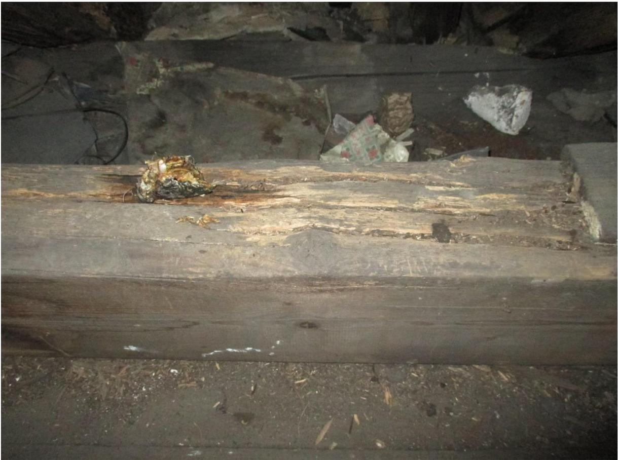
**Abbildung 21** Feuchtigkeit und Abnutzung am Oberzug
