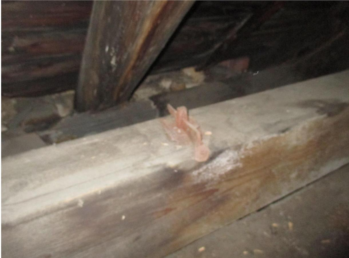
**Abbildung 13** Oberzug mit Stahlankern
