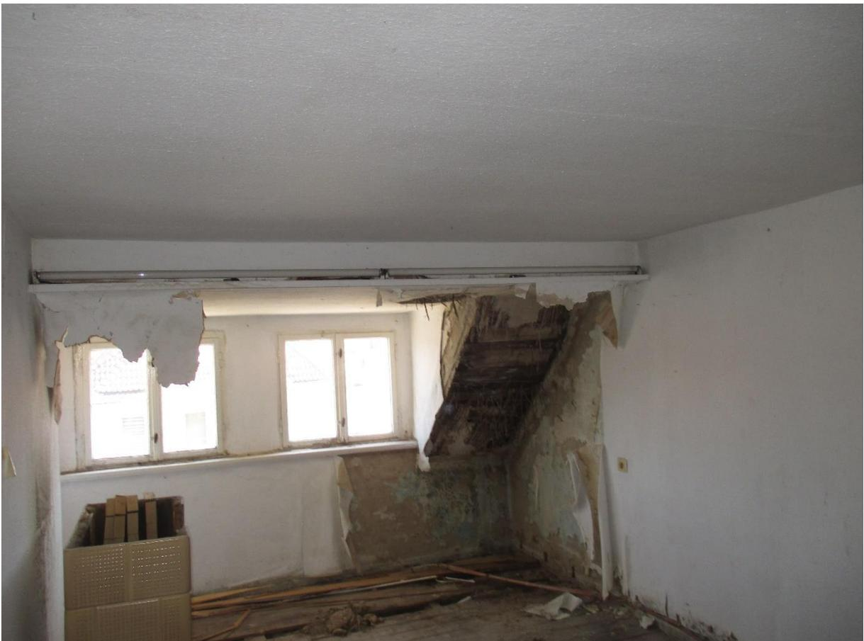
**Abbildung 12** Feuchte Dachschalung in Raum 6 (S61)
