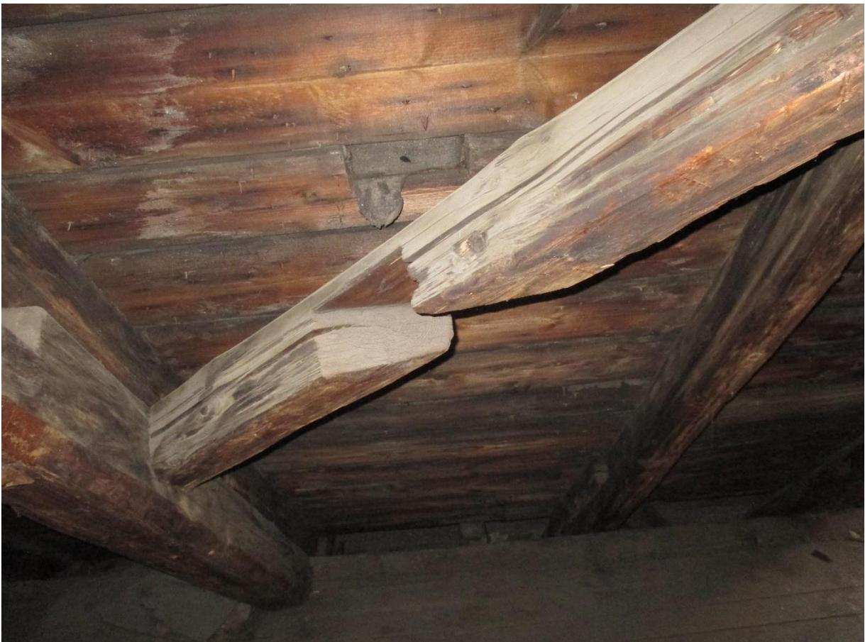
**Abbildung 24** Fehlender Zwischenriegel im mittleren Gebindefeld (muldenseitig)
