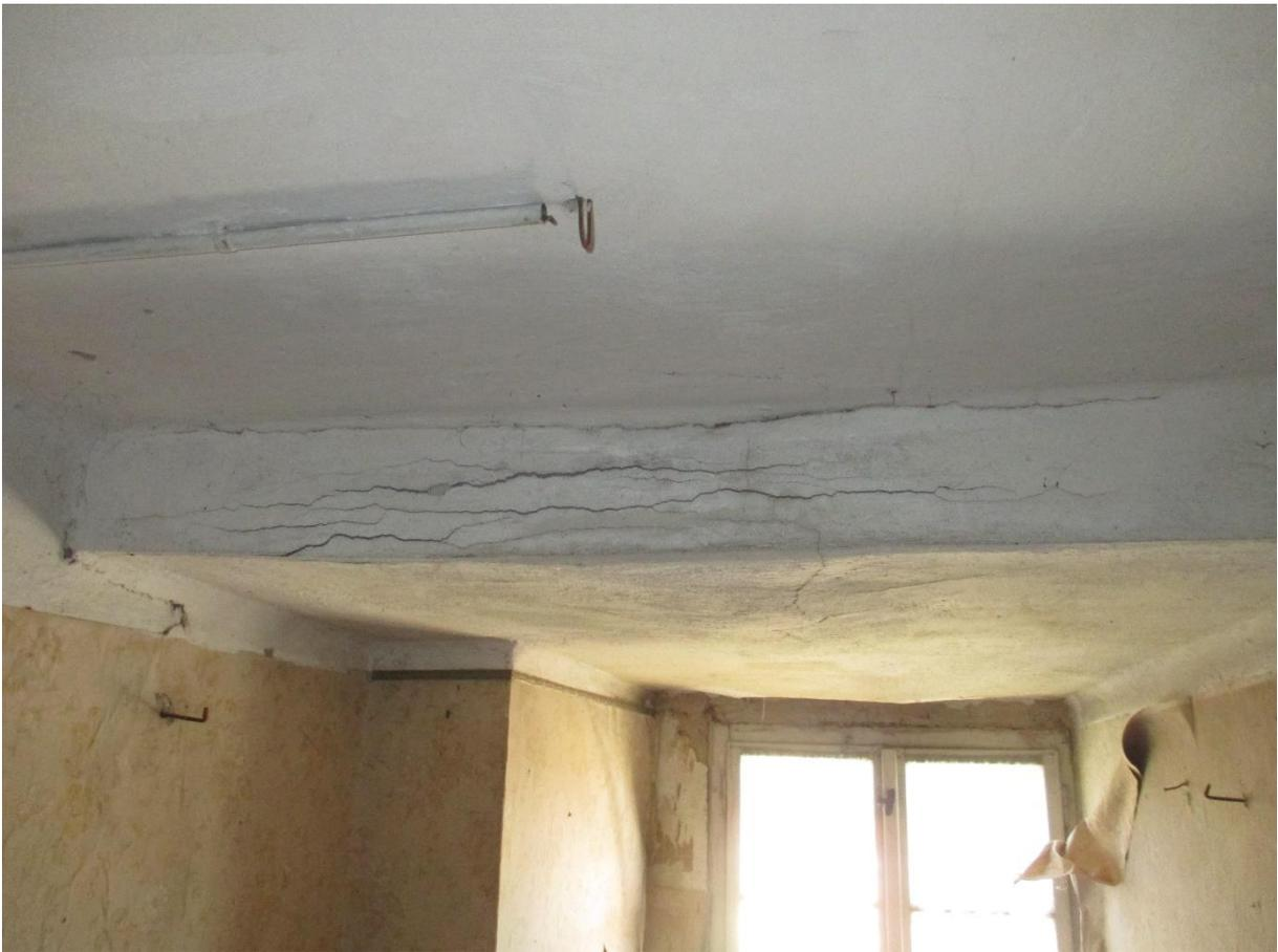
**Abbildung 5** Risse aufgrund von Durchbiegung am Unterzug in Raum 2 (S23)
