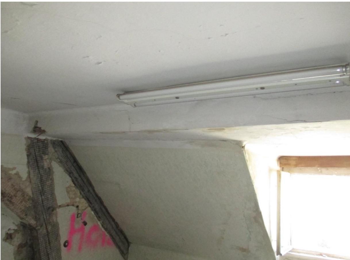
**Abbildung 2** Durchbiegung am Unterzug in Raum 1 (S13.1)
