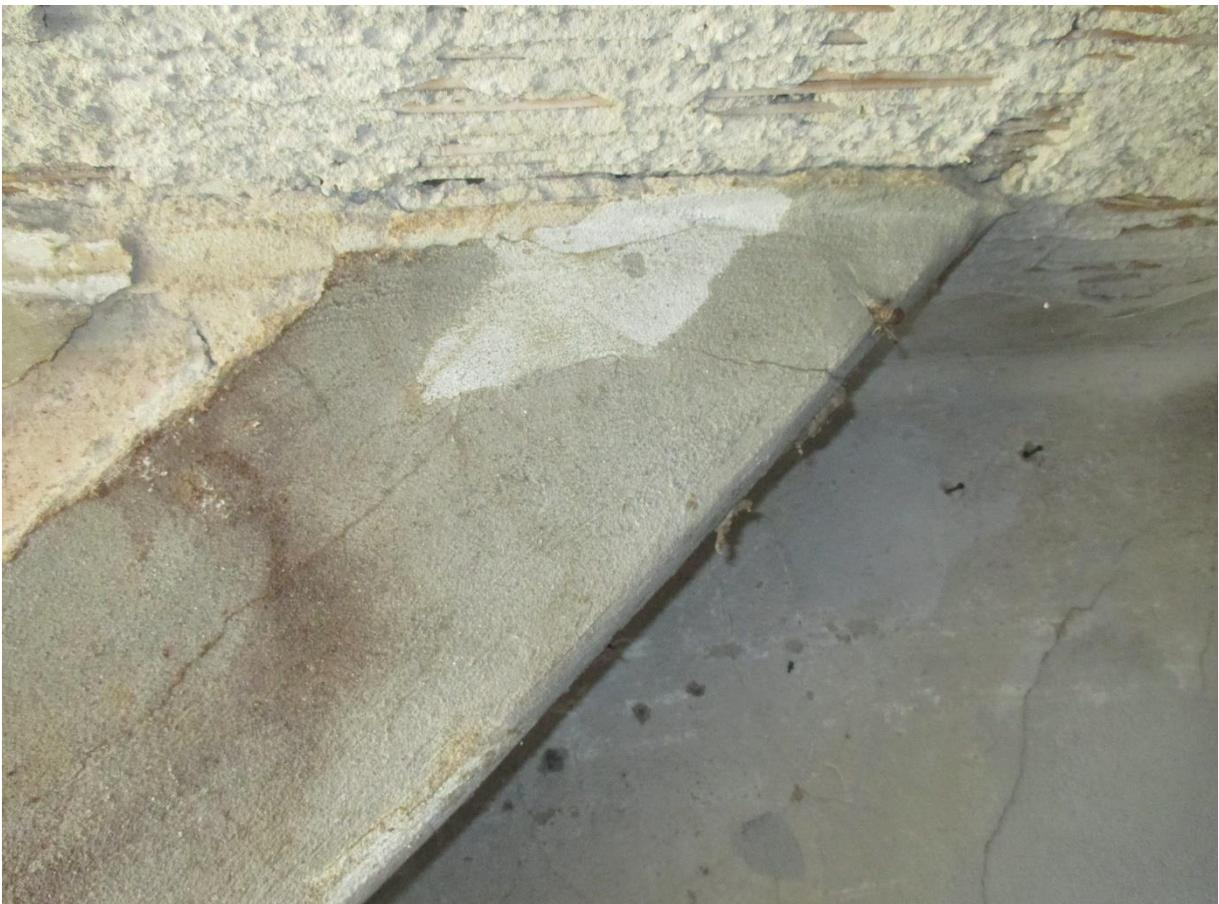
**Abbildung 6** Feuchtigkeit an der Stuhlsäule in Raum 3 (S31)
