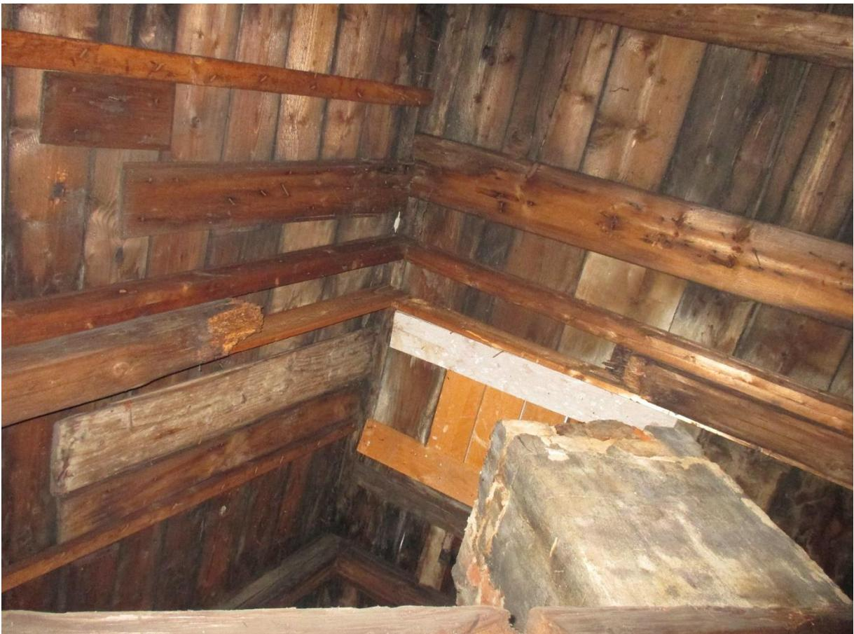
**Abbildung 14** Durchgefaltete Sparren am Schornstein (SD1.1 und SD2.1)
