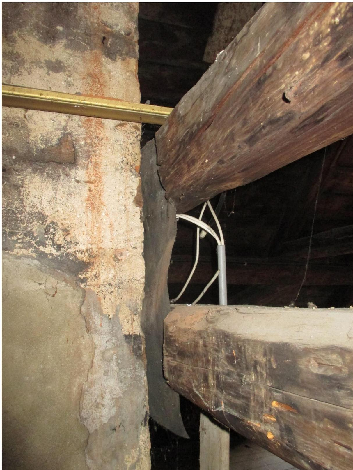
**Abbildung 25** Aussparung in Kehlbalken und Spannriegel am Schornstein
