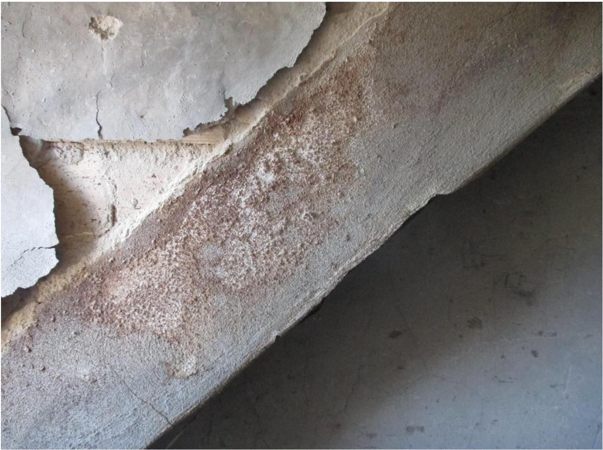
**Abbildung 7** Pilzbefall an der Stuhlsäule in Raum 3 (S32)
