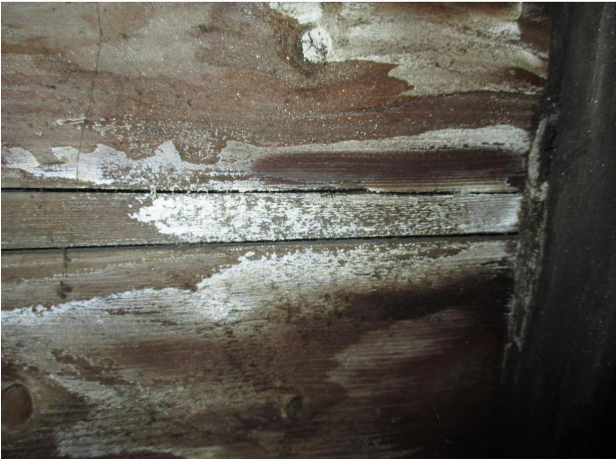
**Abbildung 15** Feuchtigkeit und Pilzbefall an Dachschalung (SD1.2 & SD2.2)
