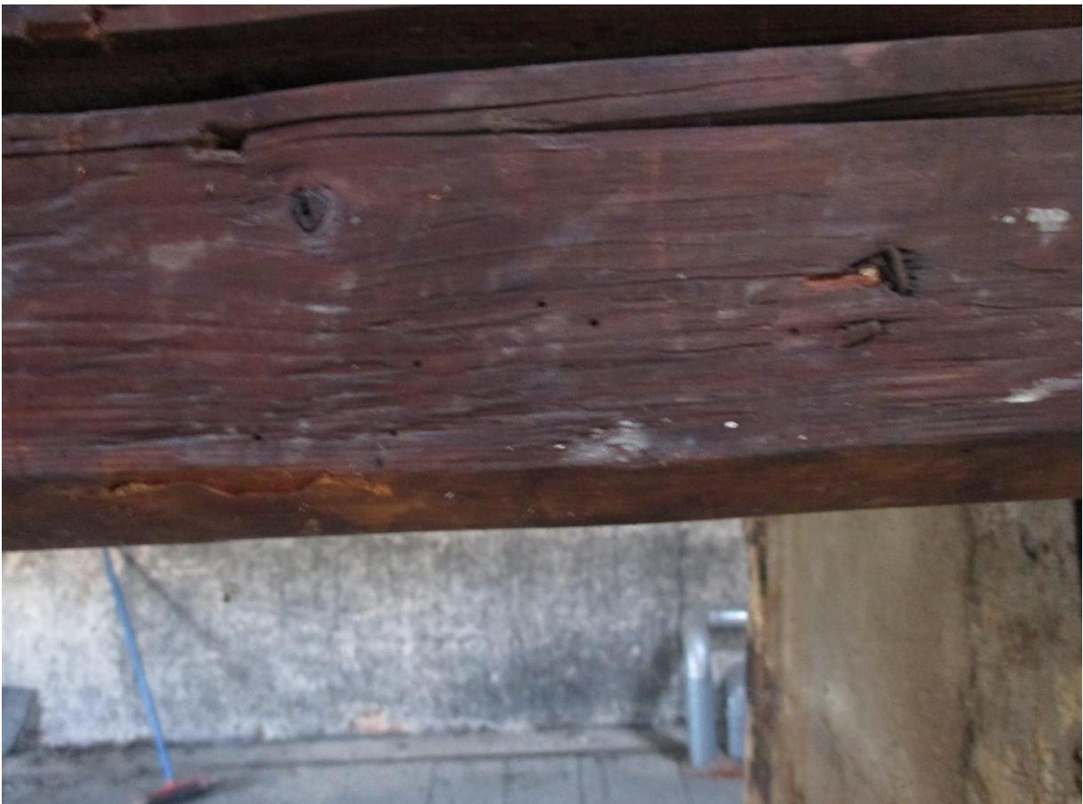
**Abbildung 18** Fraßlöcher im Spannriegel (SD4.1)
