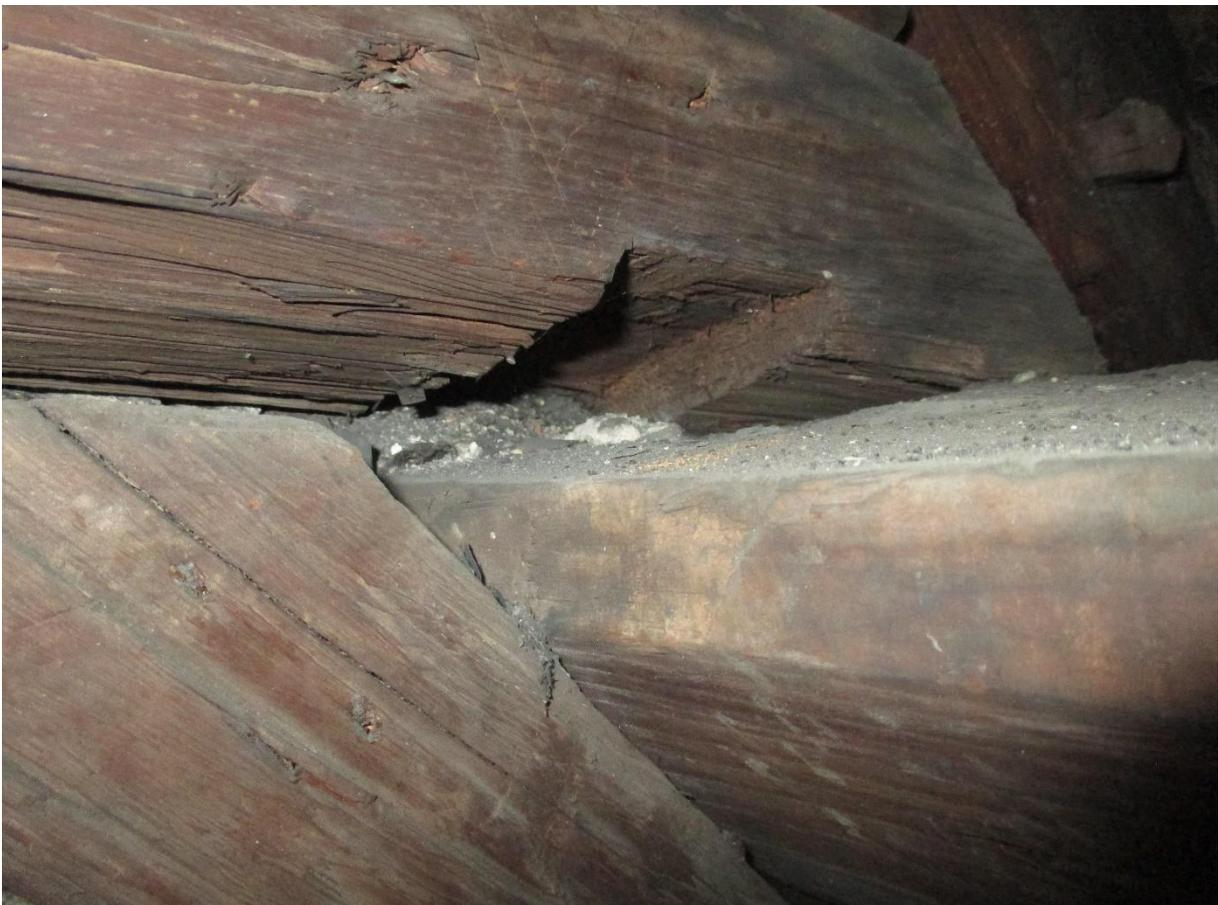
**Abbildung 20** Verformungen am östlichen Stuhlgebände (SD3.2)
