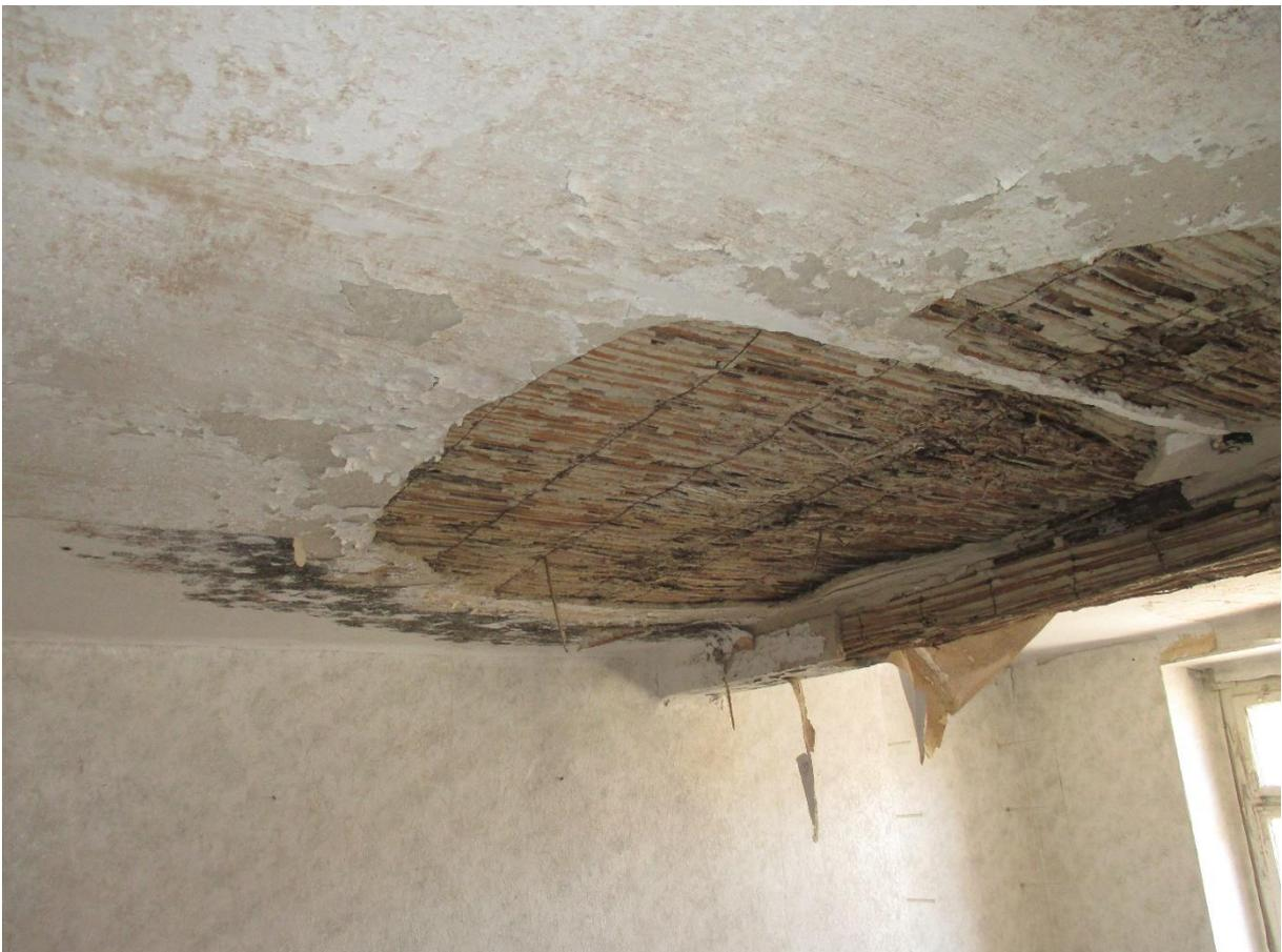
**Abbildung 10** Durchfeuchtung an der Gaube in Raum 5 (S51)
