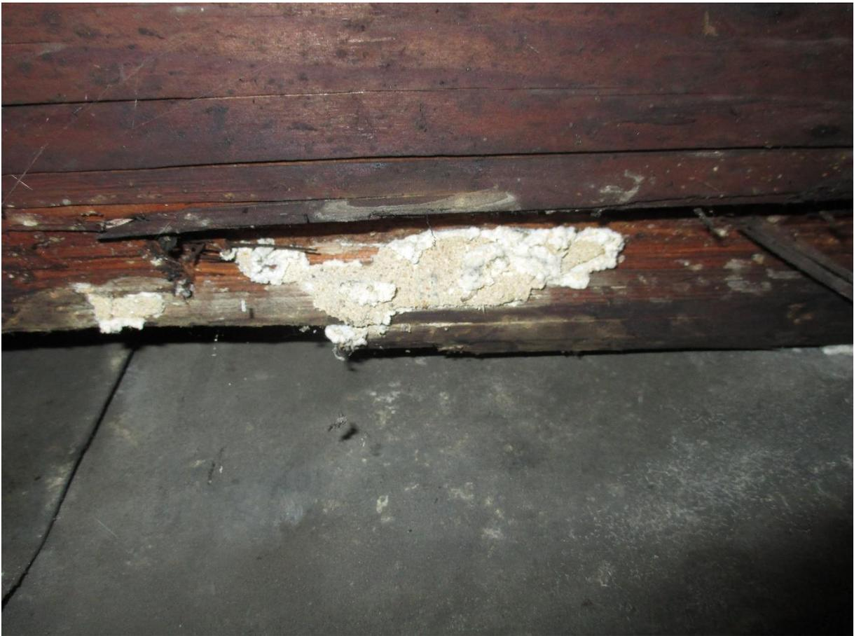
**Abbildung 17** Feuchtigkeit und Pilzbefall an Stuhlriegel (SD1.4 & SD2.3)
