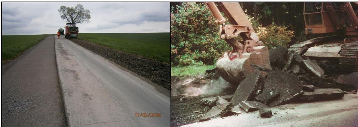
**Abbildung 9** Fräs- und Aufbruchasphalt
