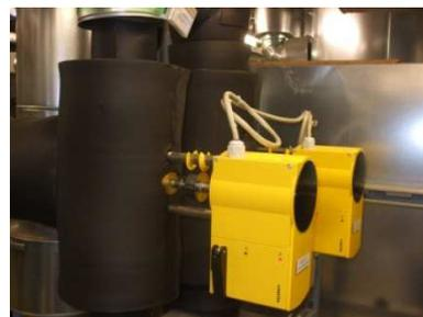
Abbildung 42 Durchgangsmotorventile Haus 40
