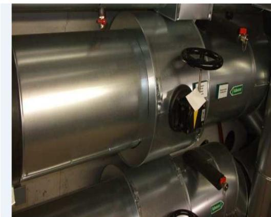
Abbildung 6 Dämmung Kollektorgang
