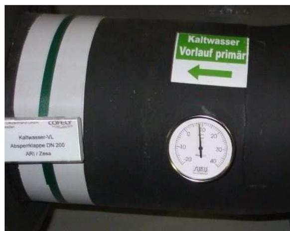
Abbildung 12 Bimetall-Thermometer
