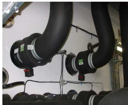
Abbildung 7 Dämmung Kältezentrale
