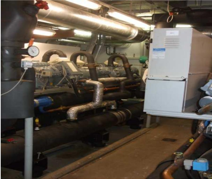
Abbildung 14 Hubkolbenverdichter Haus 25
